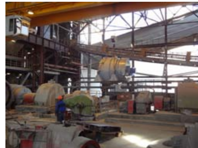
Рис. 3. Установка редуктора MAAG типа CPU-22/B на фундамент
