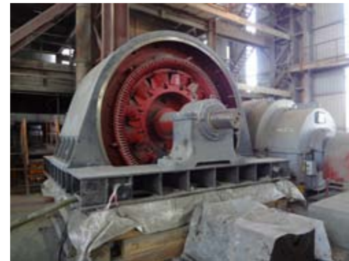
Рис. 4. Новый электродвигатель, подготовленный для установки на фундамент
